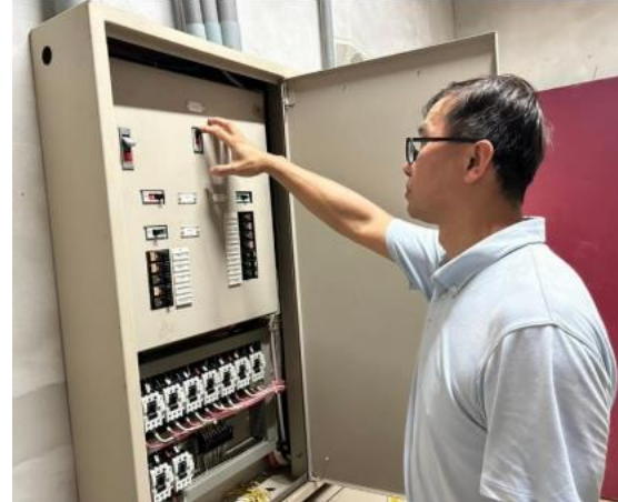
安全防護班立即關閉電源實況
