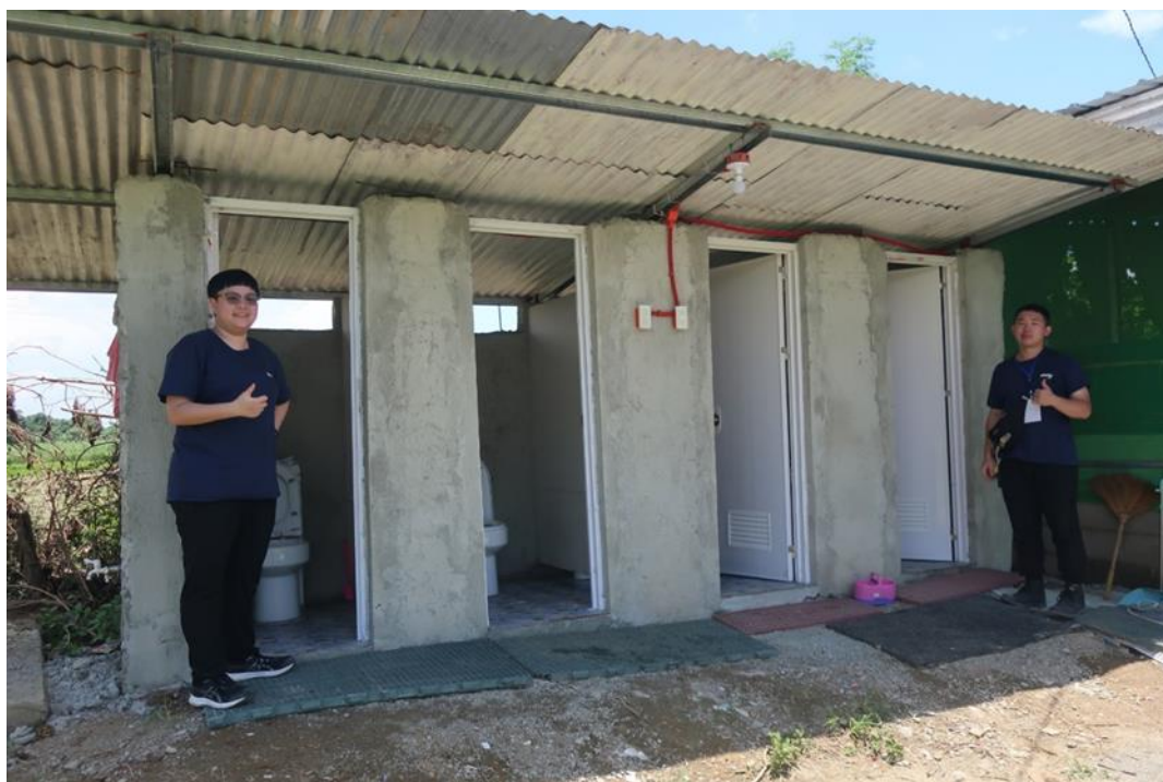
圖 4：德明科大實踐「浴廁建置計畫」，於菲律賓北部 San Joaquin 村莊新建兩間廁所及浴室。
